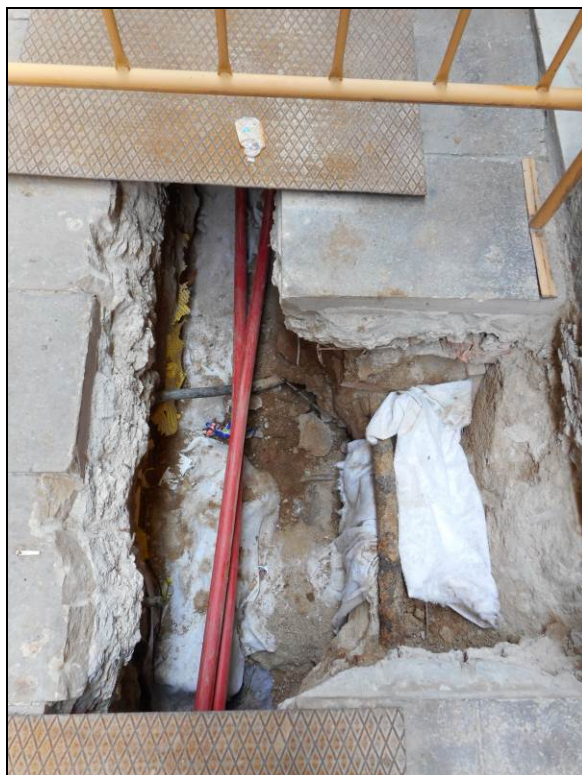
34. Cobriment amb geotèxtil de les restes de la fonamentació d'un dels pilars de l'aqüeducte romà de la ciutat de Barcino .
