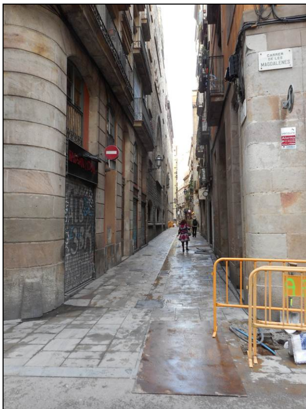
1. Vista del carrer de Montsió en direcció Oest, inici dels treballs.
