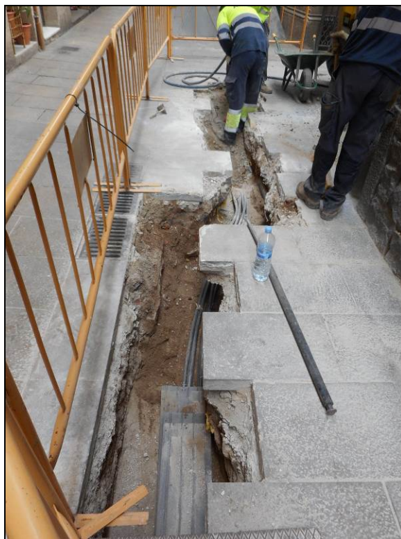
28. Tram final de la rasa al carrer de Montsió, davant el núm.. 5. S'aprecien els serveis instal·lats recentment.
