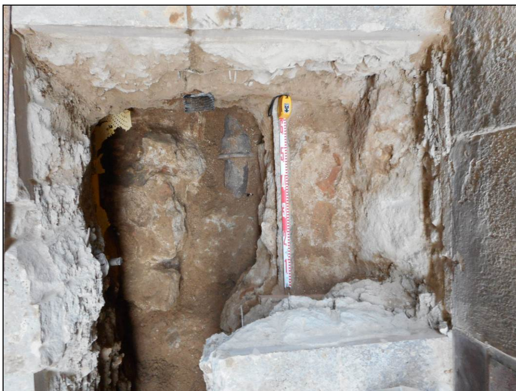
Restes de la fonamentació d'un pilar de l'aqüeducte dins una de les cales de sondeig de la rasa, efectuades amb anterioritat al control arqueològic.
