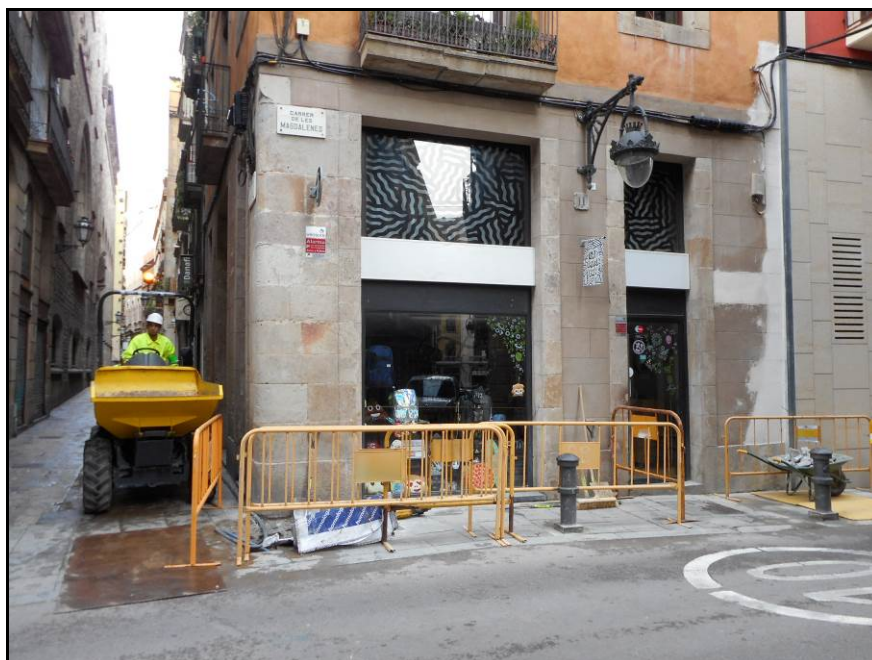
2. Vista general del xamfrà del carrer de Montsió amb Magdalenes. Inici dels treballs de realització de la rasa.
