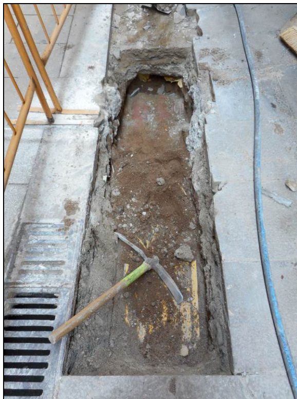
25. Tram de la rasa al carrer de Montsió, davant el núm. 5. S'aprecien els serveis instal·lats recentment.
