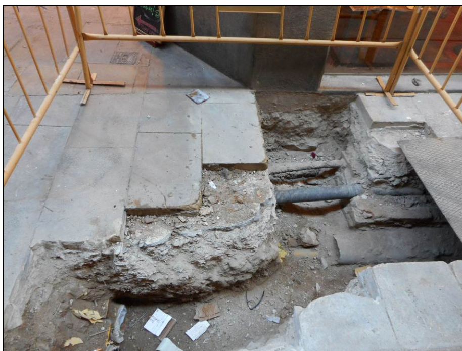
22. Tram final de la rasa al xamfrà amb el Carrer de d'Amargós.
