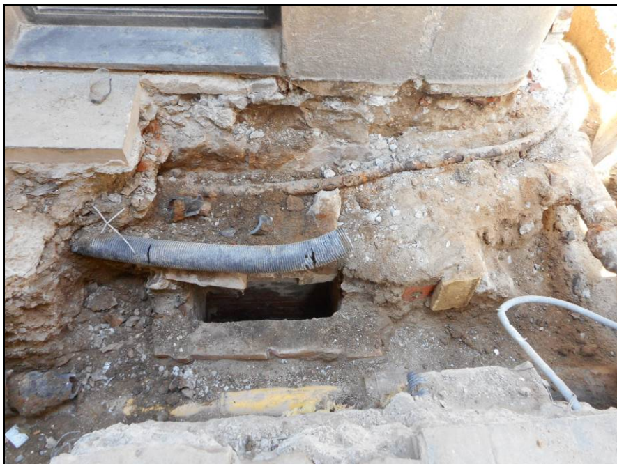
7. Embornal o registre de claveguera corresponent a la canalització d'aigües residuals del carrer, situat a tocar del xamfrà entre els carrers Montsió i Magdalenes.
