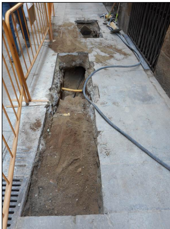
26. Tram de la rasa al carrer de Montsió, davant el núm.. 5. S'aprecien els serveis instal·lats recentment.
