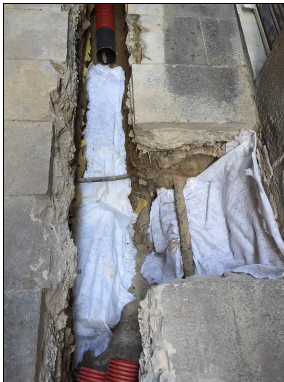
37. Cobriment amb geotèxtil de les restes de la fonamentació d'un dels pilars de l'aqüeducte romà de la ciutat de Barcino .
